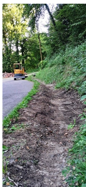
Curage de la rigole pluviale sur la route de Tigneux
